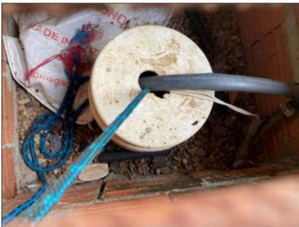
Imagem: Poço artesiano de onde o empregador retirava água para fornecimento aos empregados.
