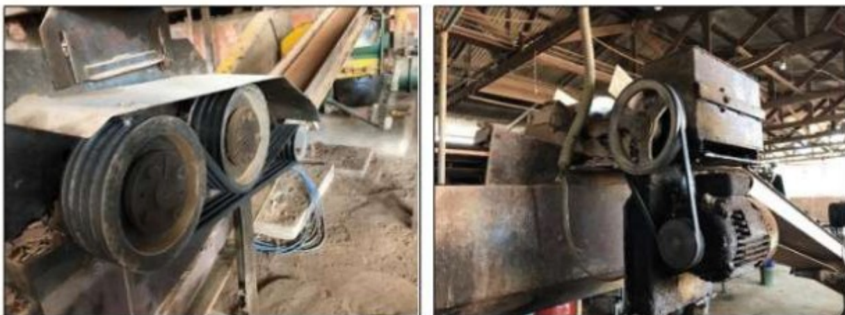
Imagens: Transmissões de força de máquinas expostas.
