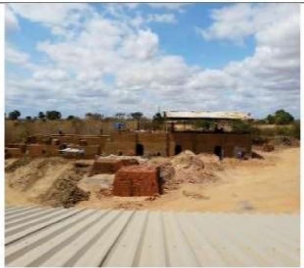
Construção do forno
