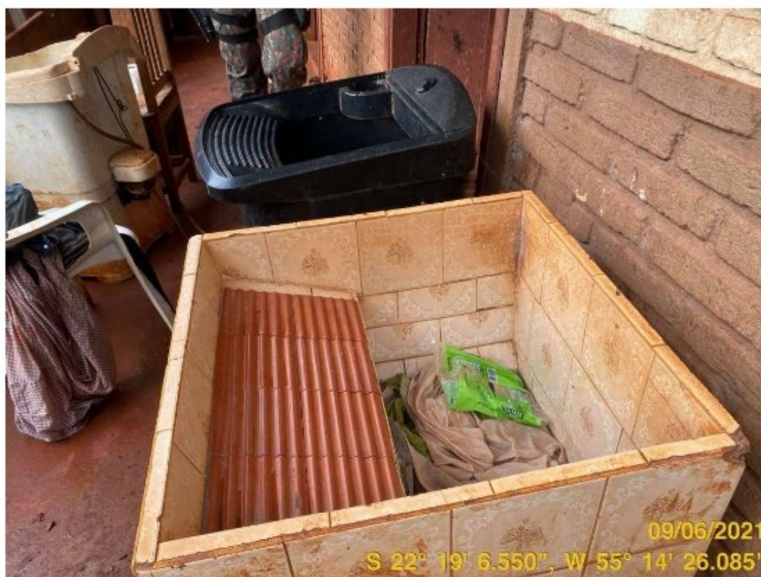
Foto 13: Tanque Sem Ligação de Água
