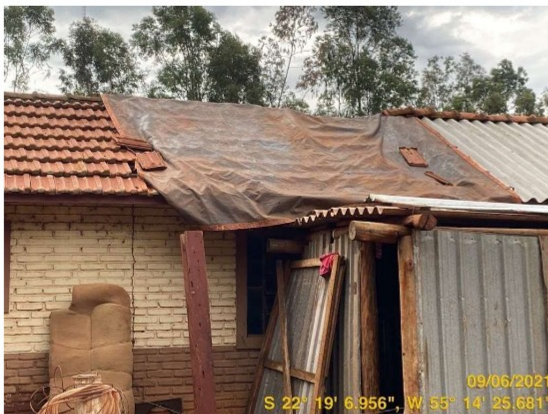
Foto 06: Alojamento dos Trabalhadores Indígenas – Cobertura
