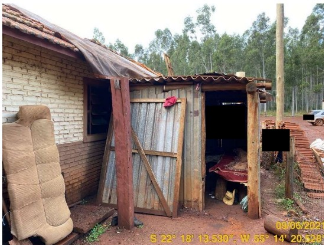
Foto 05: Alojamento dos Trabalhadores Indígenas – Parte Externa
