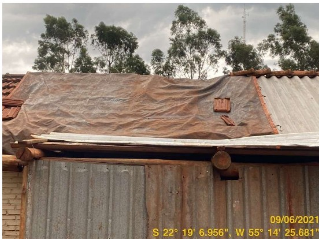
Foto 07: Alojamento dos Trabalhadores Indígenas – Cobertura
