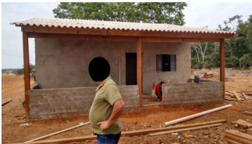
Foto 2: obra da casa sendo construída para uso da empregadora fiscalizada.
