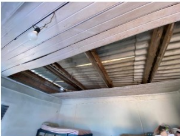
Imagens do forro do alojamento danificado e instalação elétrica exposta.
