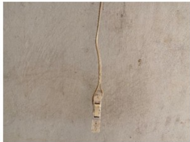
Imagens do forro do alojamento danificado e instalação elétrica exposta.
