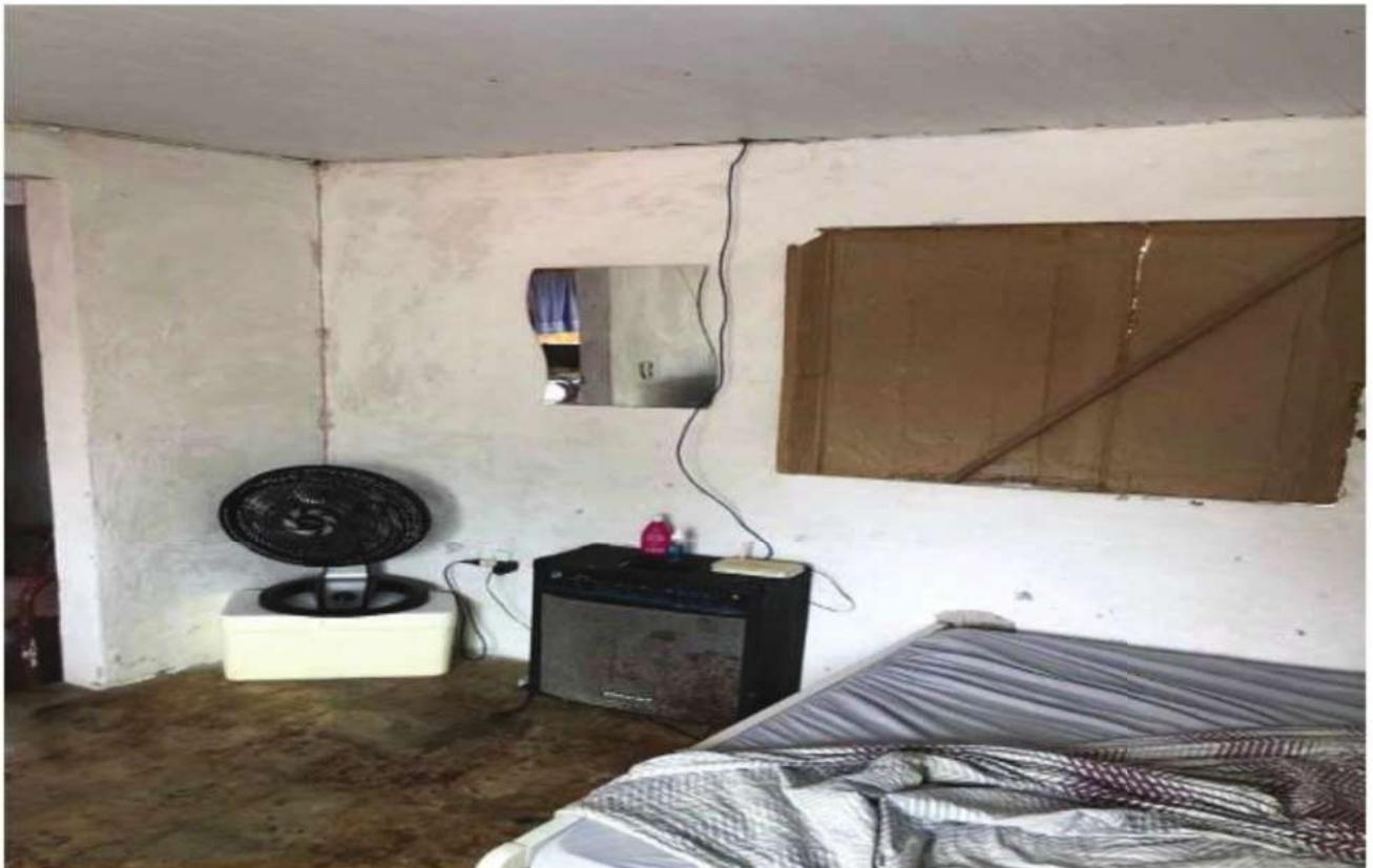
Suas paredes, teto e piso apresentam bastante manchas de mofo, provavelmente, causadas pela excessiva umidade, em razão das infiltrações e goteiras provocadas pela água da chuva.
