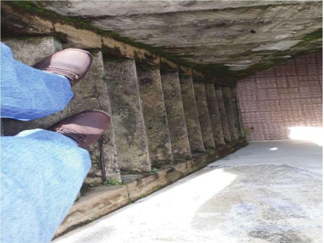
O acesso para a moradia é realizado em escada de alvenaria muito íngreme, com degraus em proporções diminutas em altura e profundidade. O risco de acidente é extremo, principalmente aos idosos.
