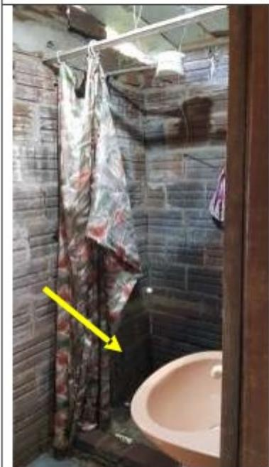
Instalação sanitária sem revestimento nas paredes e piso do box, dificultando a higienização. Instalação elétrica precária e forro em madeira.
