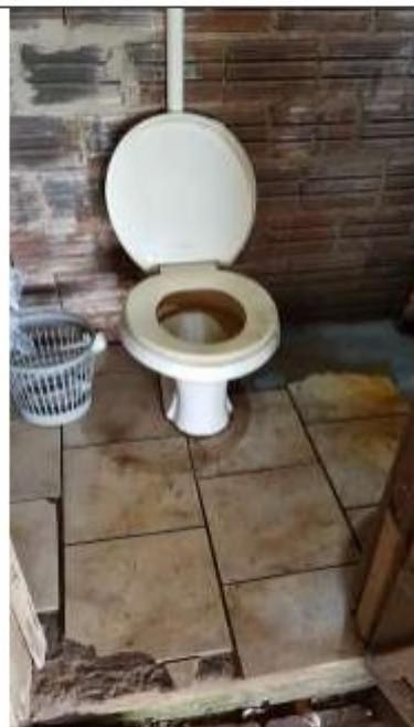
Inexistência de revestimento nas paredes da instalação sanitária. Piso com revestimento incompleto e com peças quebradas.
