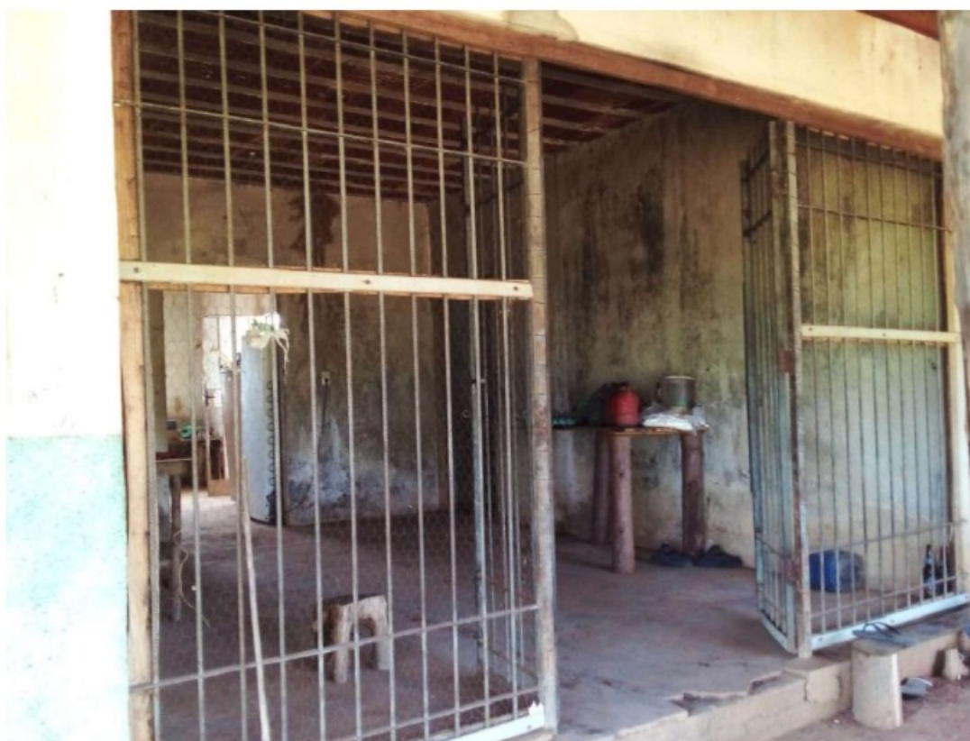
Foto da entrada do alojamento
