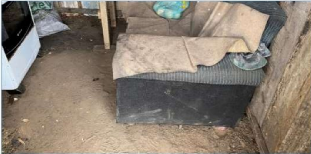
Imagens: Piso de terra da edificação onde os empregados paravam nos intervalos intrajornada.
