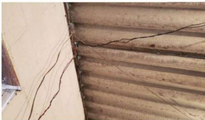
Fotos 13 e 14: interior do alojamento, com instalações elétricas com risco de choque elétrico e sem proteção dos componentes por material isolante.
