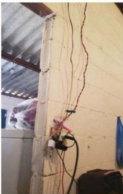
Fotos 13 e 14: interior do alojamento, com instalações elétricas com risco de choque elétrico e sem proteção dos componentes por material isolante.
