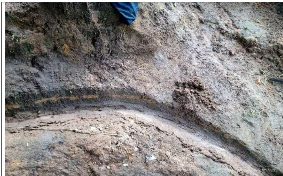
Valeta feita ao redor da moradia para escoamento da água da chuva
