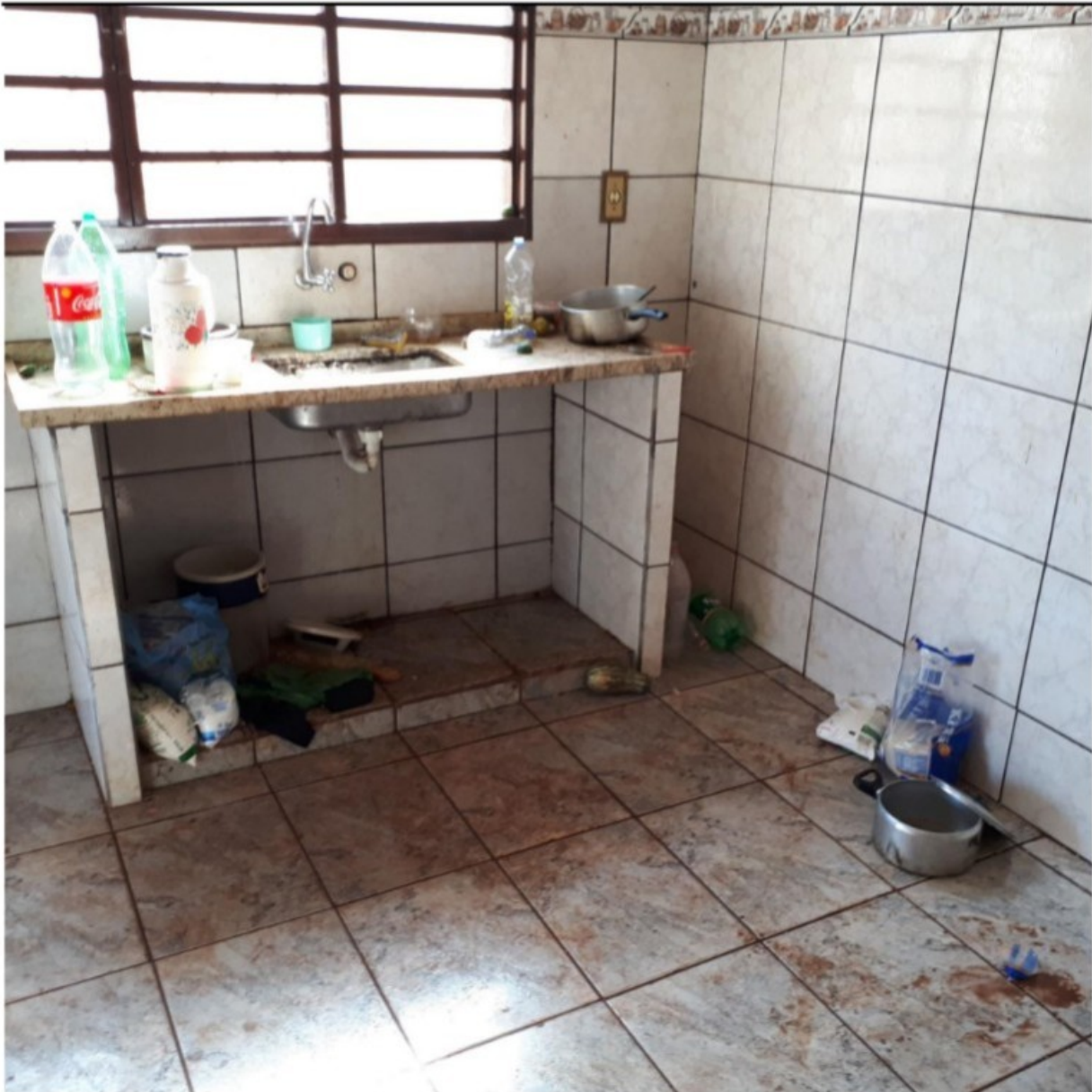
Condições de asseio da mesma residência em questão
