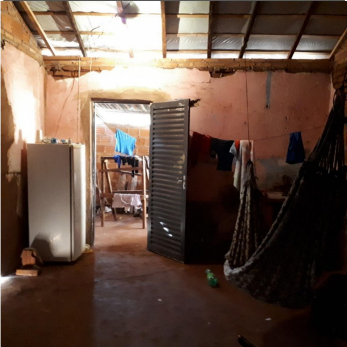
Condições de conservação e higiene do outro cômodo utilizado pelos empregados de [REDACTED] - anexo à casa
