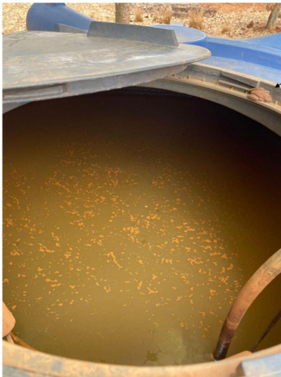
Recipiente onde era armazenada a água utilizada pelos trabalhadores
