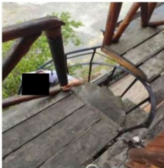
Foto 10: Piso desnivelado.
