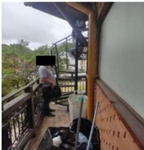
Foto 9: Acesso ao local das caixas d'água.
