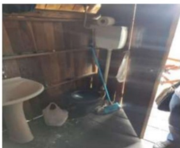
Foto 5: Assento sanitário, sem gabinete, instalado próximo às caixas d'água.
