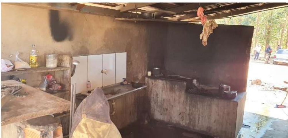
Imagem 4. Vista geral da área utilizada para preparo de alimentos. Registro fotográfico efetuado em 29/09/2021.
