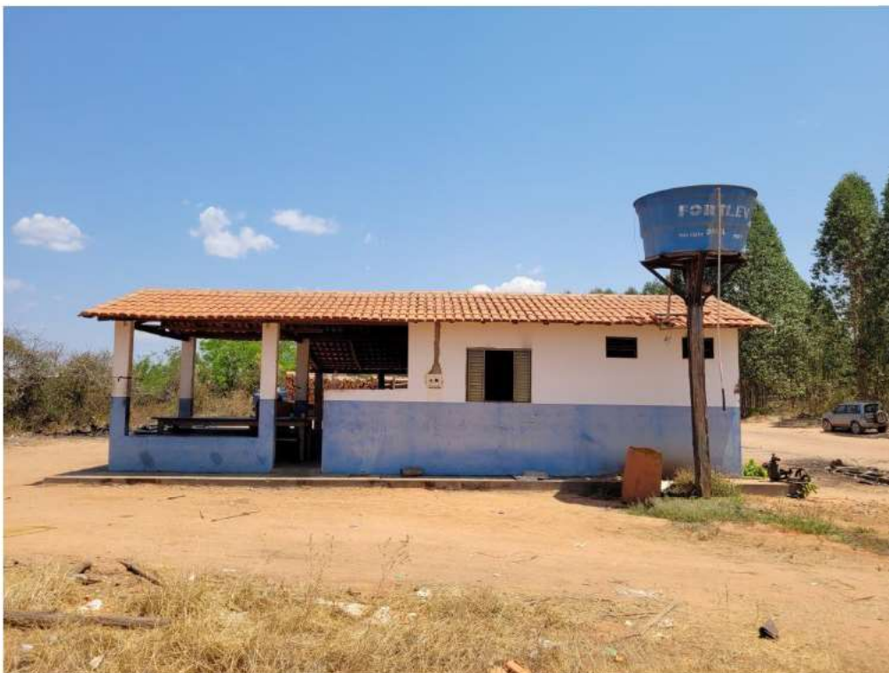
Imagem 3. Vista geral da edificação próxima aos fornos. Registro fotográfico efetuado em 29/09/2021.
