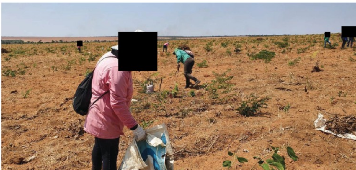
Imagem 2. Trabalhadores laborando na catação manual de tocos e raízes. Registro efetuado em 27/09/2021.
