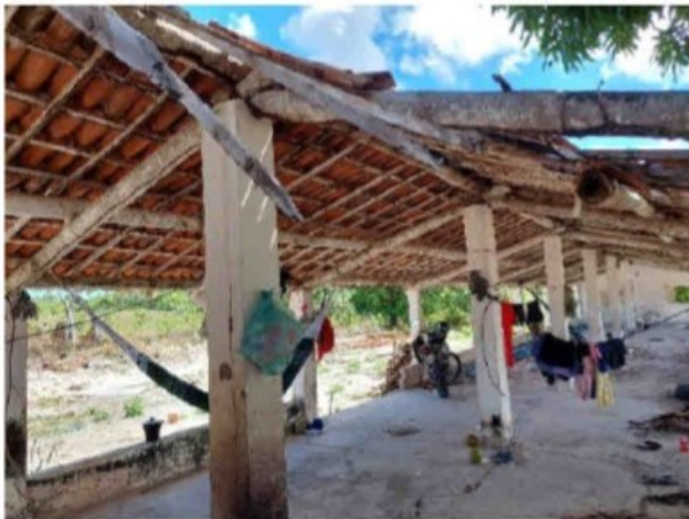
Figura 15 Vista do galpão com os trabalhadores no seu interior. Pela foto, é possível verificar a falta de paredes laterais, de portas e janelas e principalmente o telhado em situação precária, com risco de queda de materiais.
