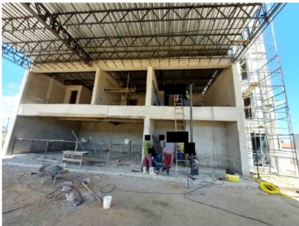
Figura 1 Canteiro de obras fiscalizado.
