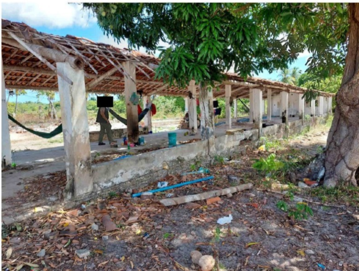
Figura 3 Antigo galpão utilizado para alojar trabalhadores.
