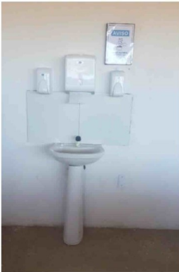
Figura 45 Lavatório com papel e sabão instalada após a intervenção da fiscalização.
