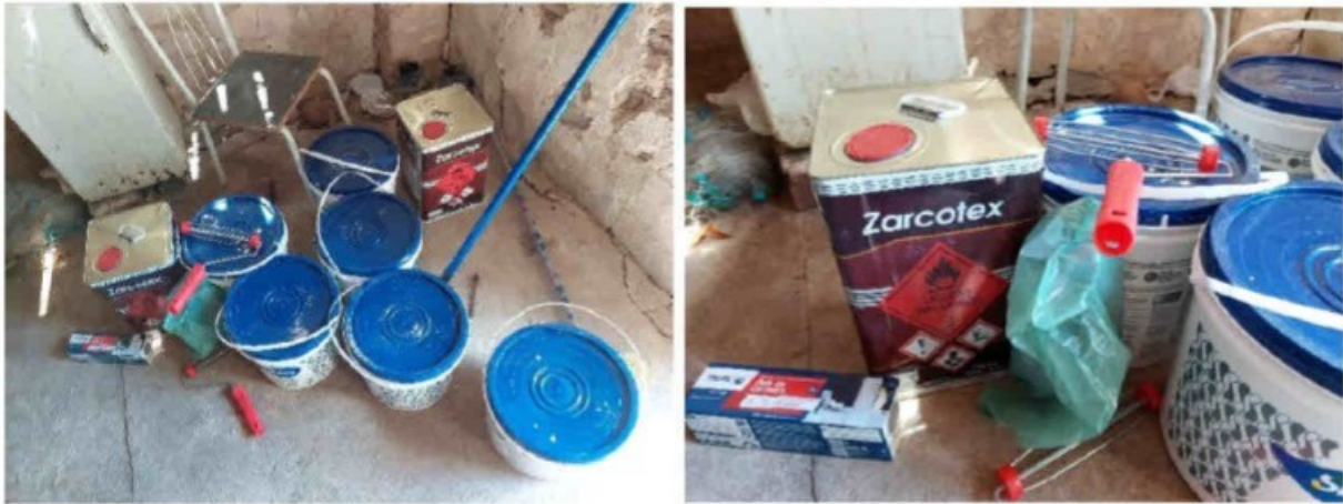
Figura 27 e 28 Depósito de material inflamável no mesmo ambiente onde os trabalhadores estavam alojados.
