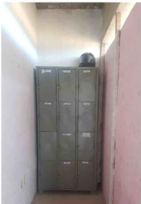
Figura 7 Armário instalado após início da fiscalização.
