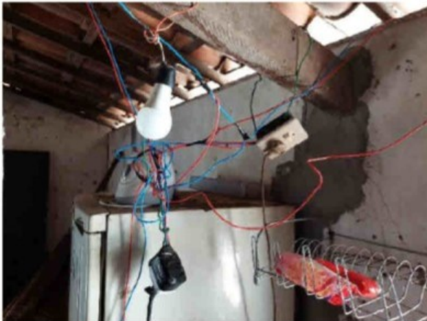
Figura 25 e 26 Gambiarras elétricas.
