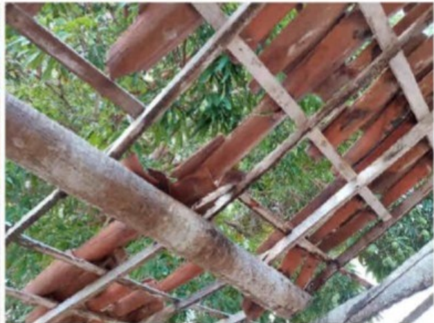
Figura 15 Vista do galpão com os trabalhadores no seu interior. Pela foto, é possível verificar a falta de paredes laterais, de portas e janelas e principalmente o telhado em situação precária, com risco de queda de materiais.
