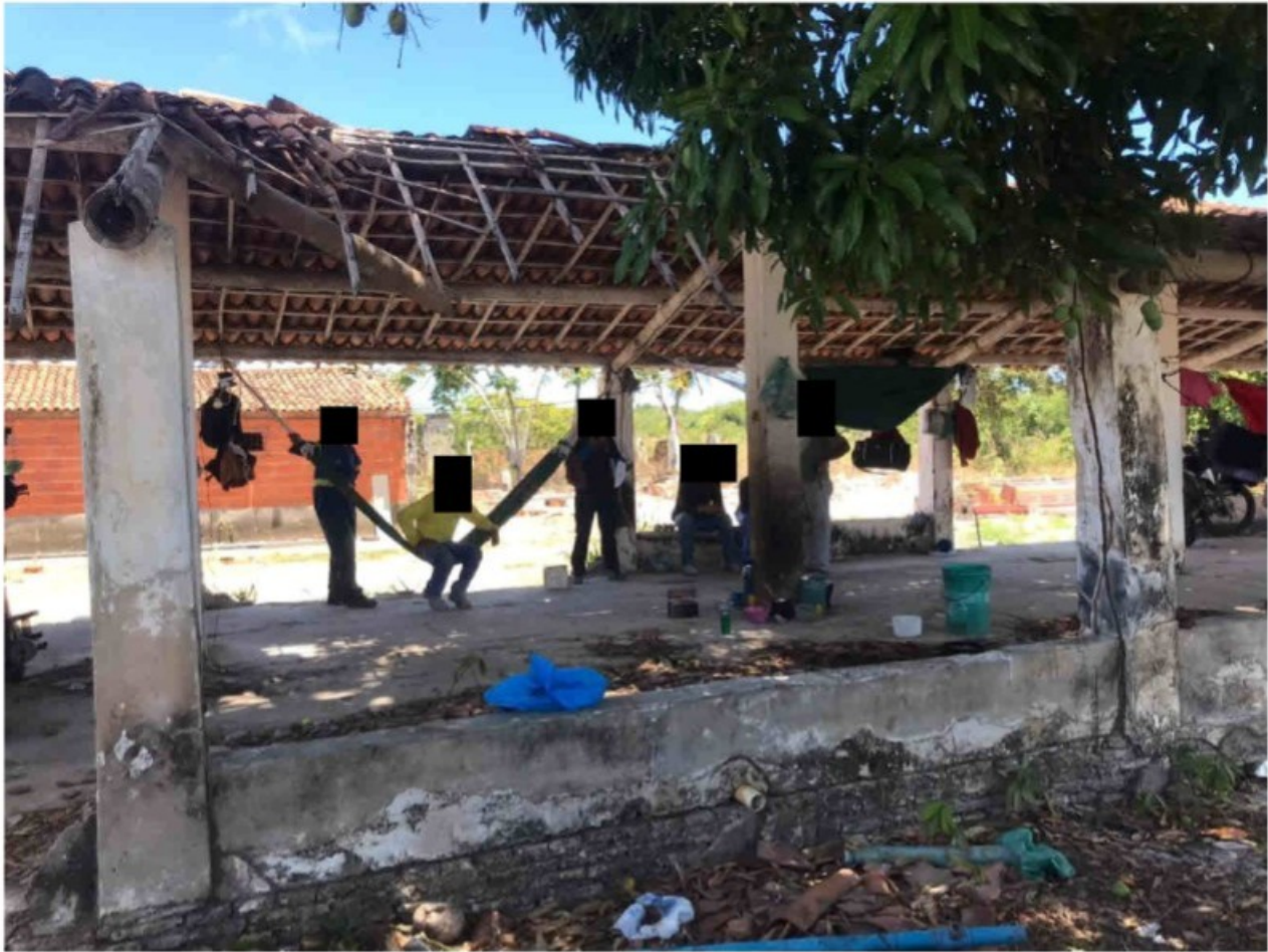
Figura 15 Vista do galpão com os trabalhadores no seu interior. Pela foto, é possível verificar a falta de paredes laterais, de portas e janelas e principalmente o telhado em situação precária, com risco de queda de materiais.
