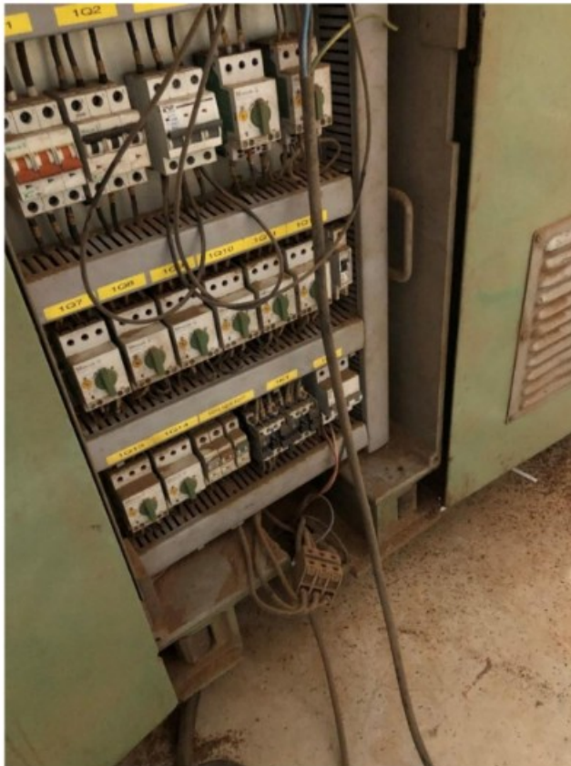
Foto 9 - Poeira de fumo junto a painel elétrico com disjuntores com partes vivas expostas.
