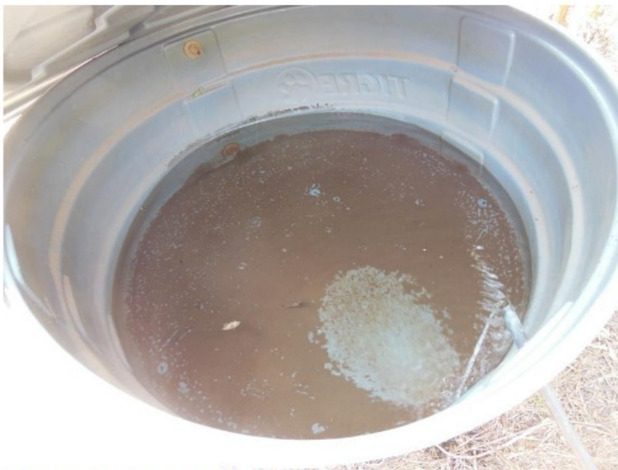
Figura 24 – No fundo da caixa de armazenamento, encontramos lama e folhas, sinais evidentes de ausência de limpeza. Fotografia feita pela fiscalização em 24/08/2021.
