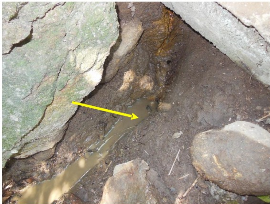
Figura 22 – Removendo os cacos de telhas, a fiscalização expos a extremidade do tubo, indicado pela seta. Ao contrário da extremidade mostrada nas figuras anteriores, aqui não havia garrafa plástica ou outro “dispositivo” para evitar o entupimento do tubo. Fotografia feita pela fiscalização em 24/08/2021.
