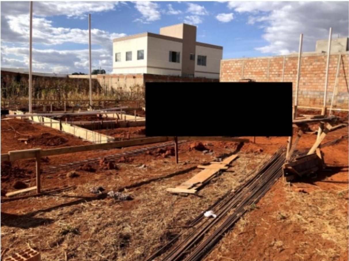
Foto 1. Vista geral do canteiro de obras. Registro fotográfico efetuado no dia 09/08/2021.
