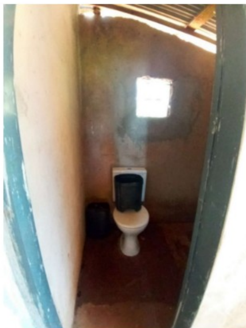
Foto 4: instalação sanitária existente nas adjacências dos alojamentos inspecionados.
