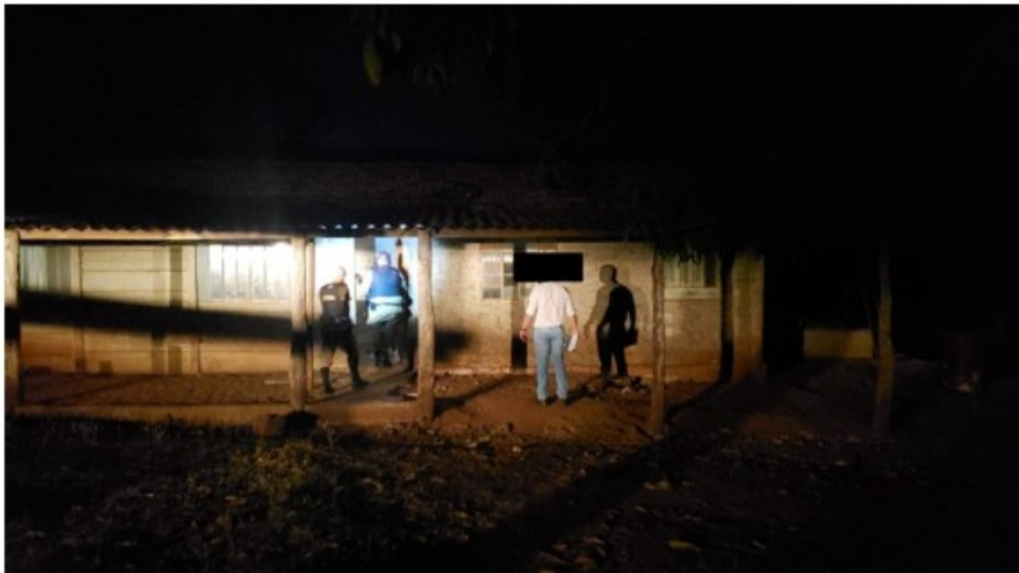
Figura 2 registro fotográfico da fachada da edificação
