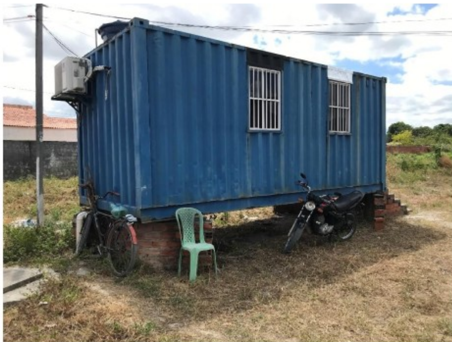
Figura 17 Contêiner onde funcionava o escritório da empresa, ao lado do alojamento dos trabalhadores dos 17 trabalhadores resgatados.
