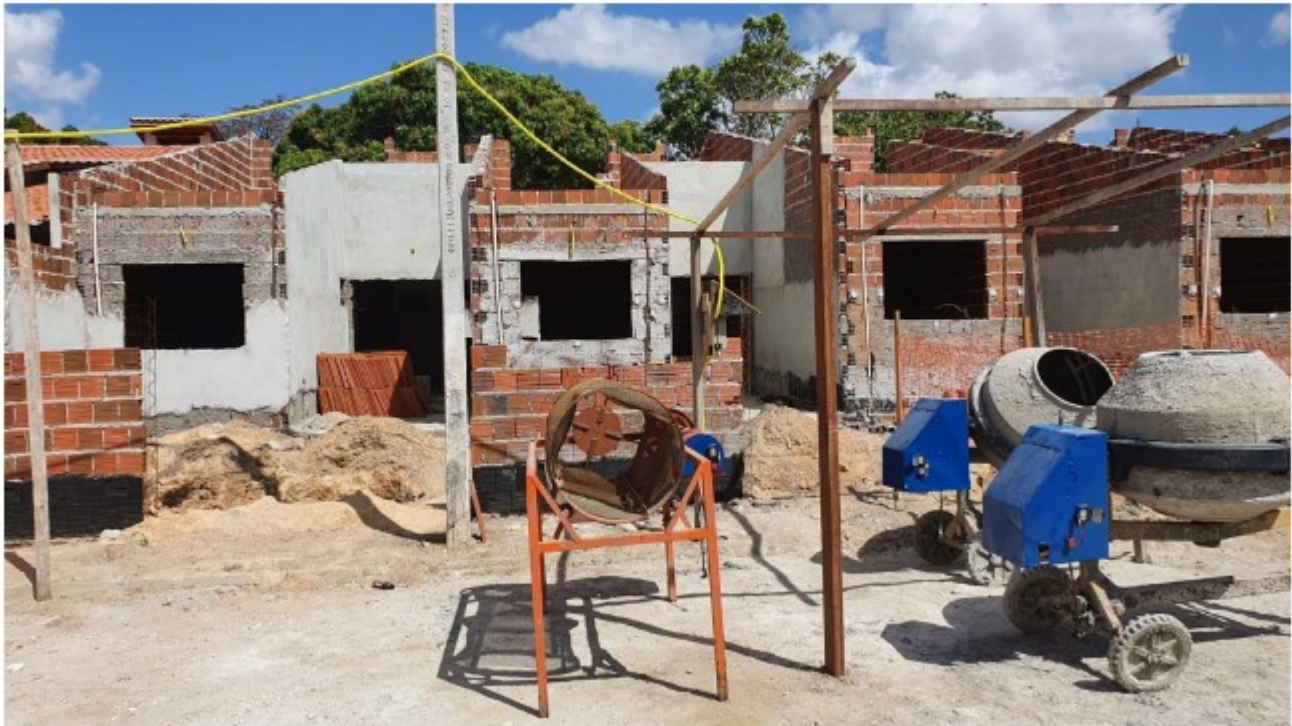
Figura 1 Canteiro de obras
