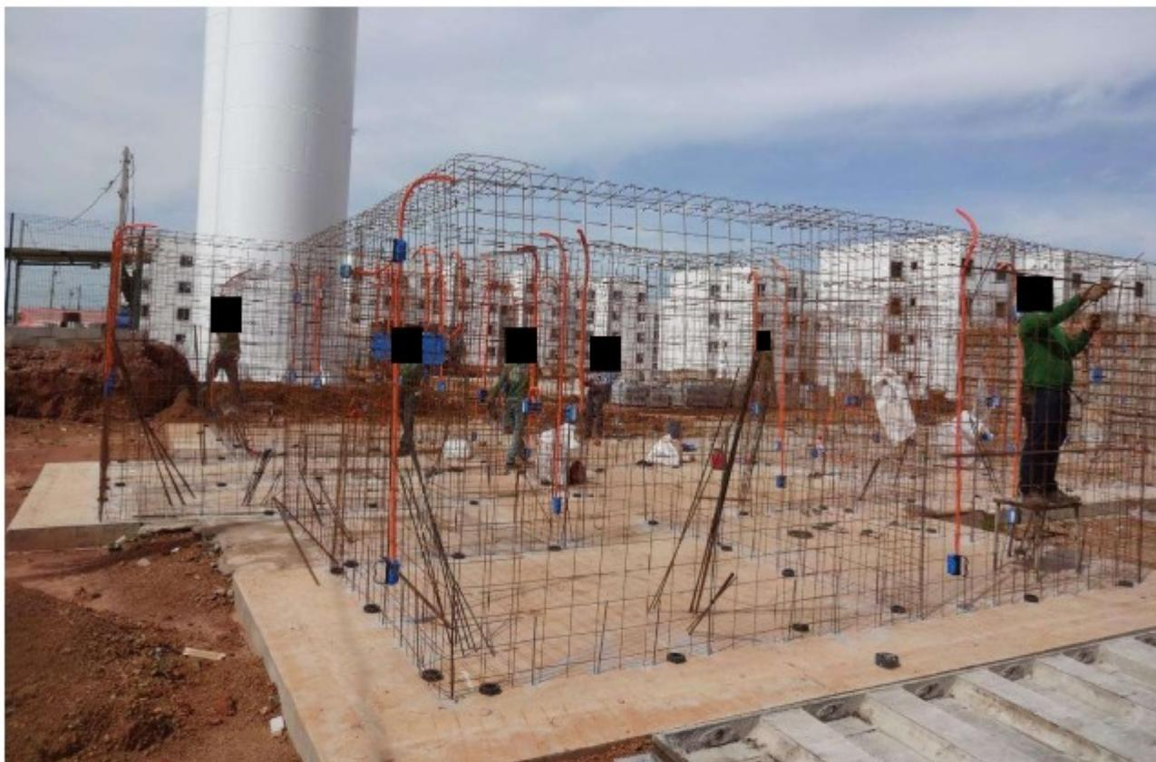
**Imagem 7 – Operários da UTZ realizando montagem de armações de ferro na obra Resid. Conquista 2.**
