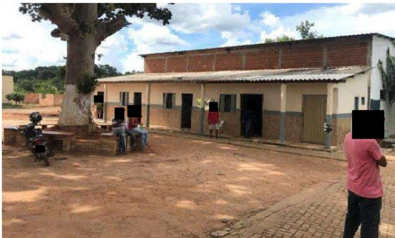
Imagem 02 – Edificação onde funciona um dos alojamentos dos internos da “Associação Resgate”.
