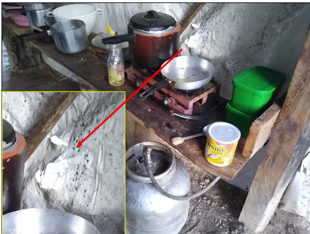
Foto: Fogão de duas bocas e botijão de gás que eram usados dentro de um dos barracos. No detalhe, buracos na lona abertos pelo calor emitido pelas chamas do fogão.
