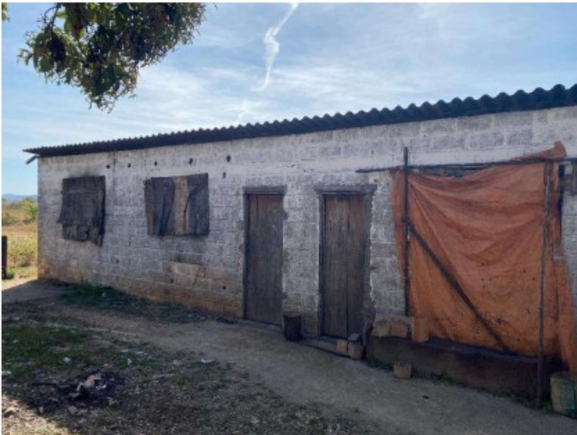
Foto 7: Área de apoio próxima à carvoaria
