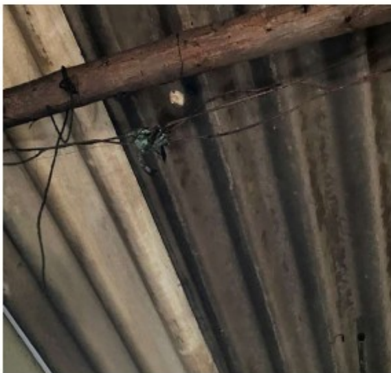
Figuras 5 e 6: instalações elétricas improvisadas no dormitório e no banheiro
