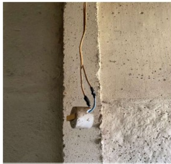
Figuras 5 e 6: instalações elétricas improvisadas no dormitório e no banheiro
