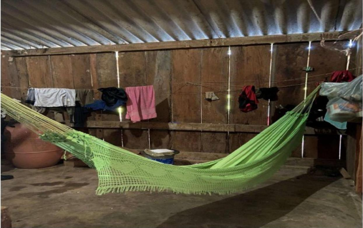
**Cômodo com estrutura de piso de cimento apresentando diversos buracos e fissuras que impossibilitavam sua higienização e paredes de madeira com frestas de significativas dimensões, tornando-as incapazes de proporcionar vedação e segurança.**
