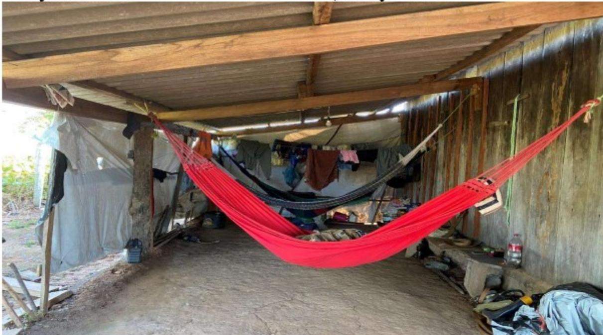
Prolongamento lateral esquerdo da casa – Sítio I, destinado ao repouso dos empregados, coberta com telha de cimento, piso de terra e proteção de paredes laterais e fundos feita com lona plástica e sem qualquer proteção de parede frontal.
