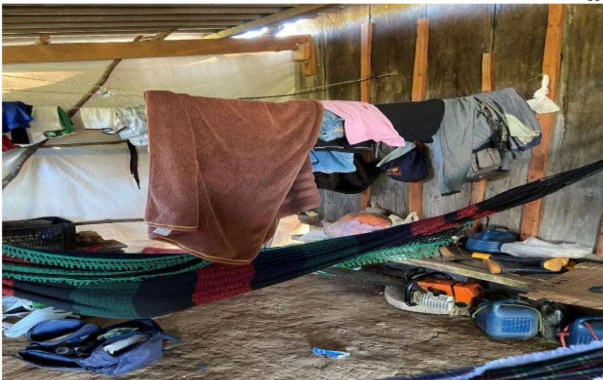
**Prolongamento lateral esquerdo da casa – Sítio I, destinado ao repouso dos empregados, coberta com telha de cimento, piso de terra e proteção de paredes laterais e fundos feita com lona plástica e sem qualquer proteção de parede frontal.**
