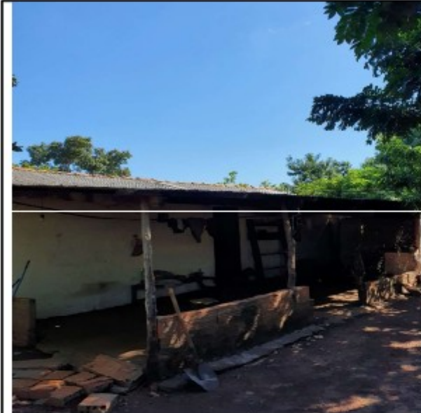
Foto 08: local onde o trabalhador estava alojado
