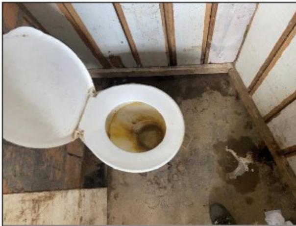
Imagens: Piso das instalações sanitárias, quebrado e com sujeiras. O vaso estava sujo e o transbordando para o chão.
