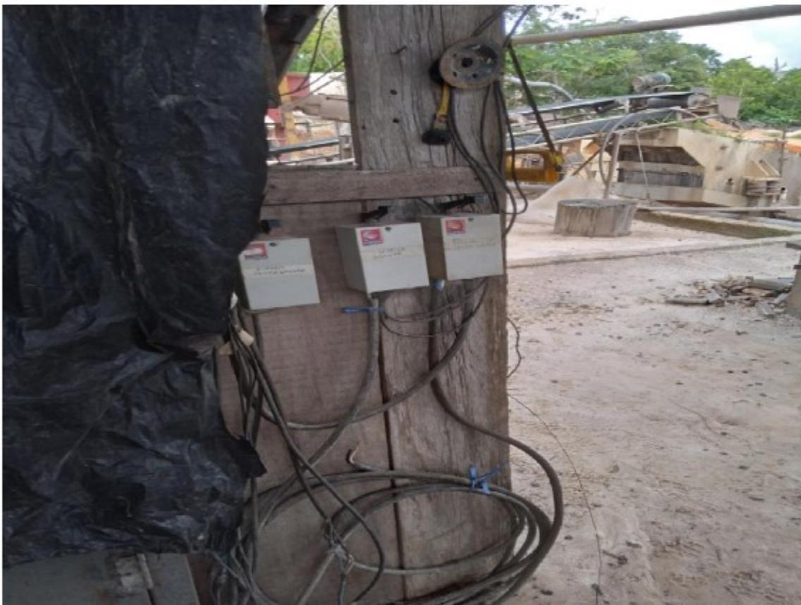
**Figura 7: dispositivos de acionamento e parada inadequados**
