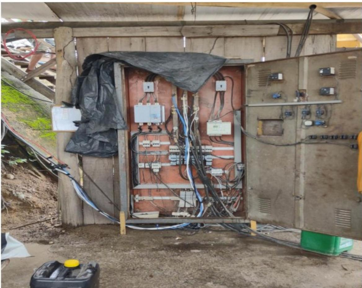
**Figura 2: painel elétrico de controle e distribuição de energia para as máquinas.**
