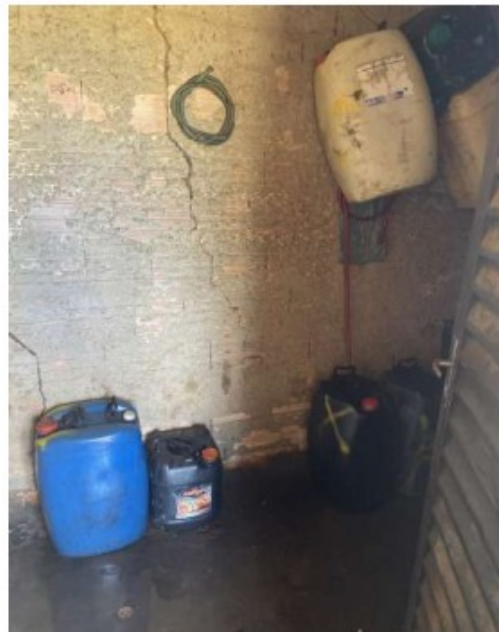
Figuras 10 e 11: cômodos utilizados para depósito de combustível na mesma edificação usada para alojamento
