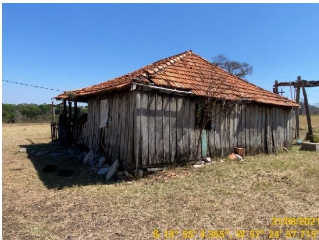
Foto 01: Edificação Disponibilizada para Alojamento do Trabalhador – Faz Baía do Cambará
