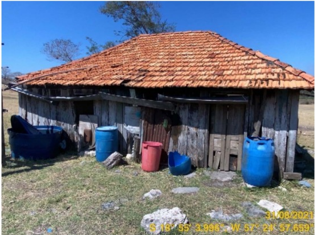
Foto 02: Edificação Disponibilizada para Alojamento do Trabalhador – Faz Baía do Cambará
