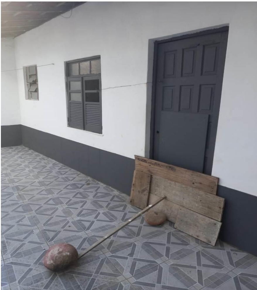
Frente do anexo onde [REDACTED] estava alojada, com proteção improvisada para impedir a entrada do cachorro que ficava solto nesta parte dos fundos da casa
