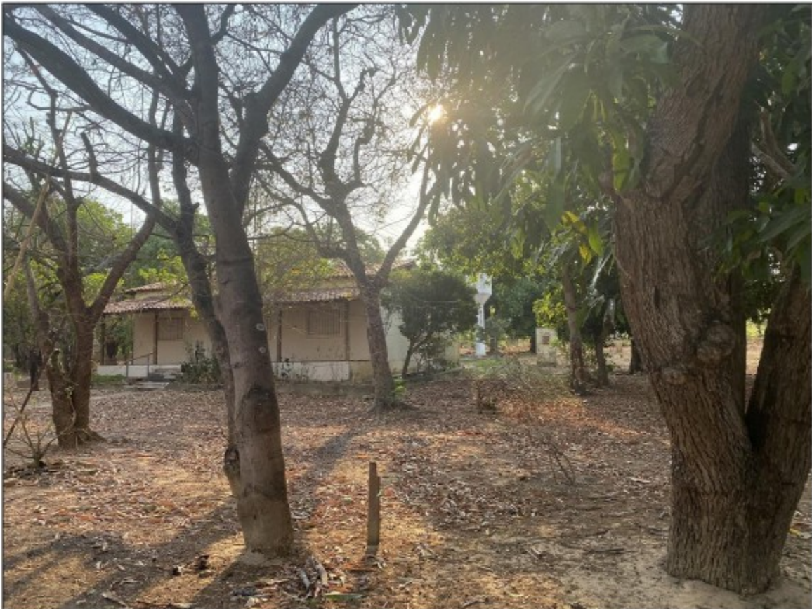
Foto 1: edificação localizada nas coordenadas geográficas informadas pelo denunciante (Notícia de Fato nº 000207.2021.03.005/2).
