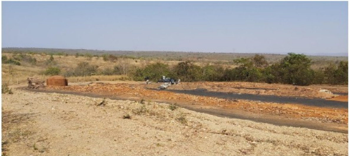
Foto 1: Visão geral de onde funcionava a carvoaria, no lado esquerdo vemos o único forno de carvão que não foi demolido.
