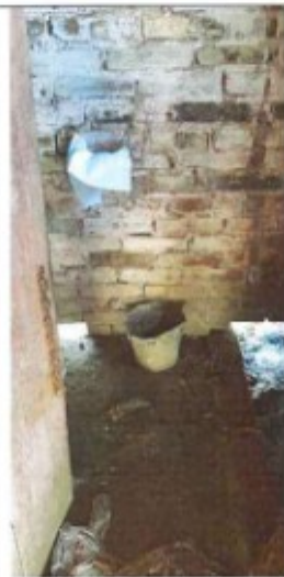
Imagens da instalação sanitária.
