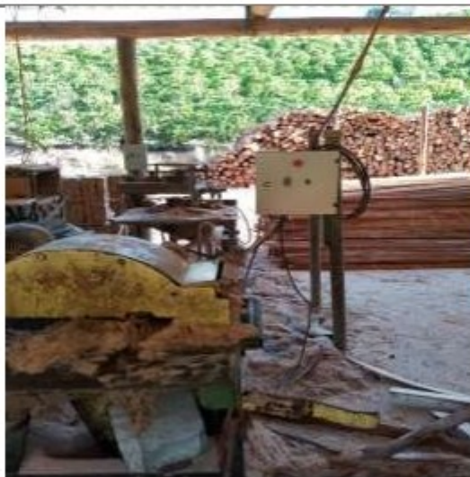
Foto enviada por e-mail após a inspeção no local, mostrando as providências tomadas com relação às instalações elétricas.
