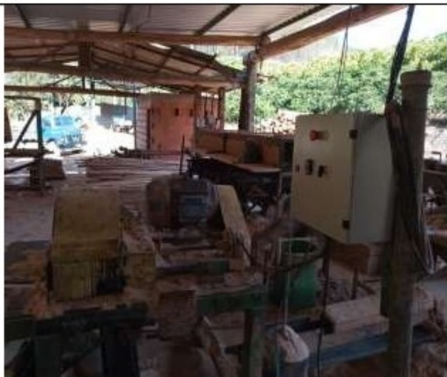
Foto enviada por e-mail após a inspeção no local, mostrando as providências tomadas com relação às instalações elétricas.
