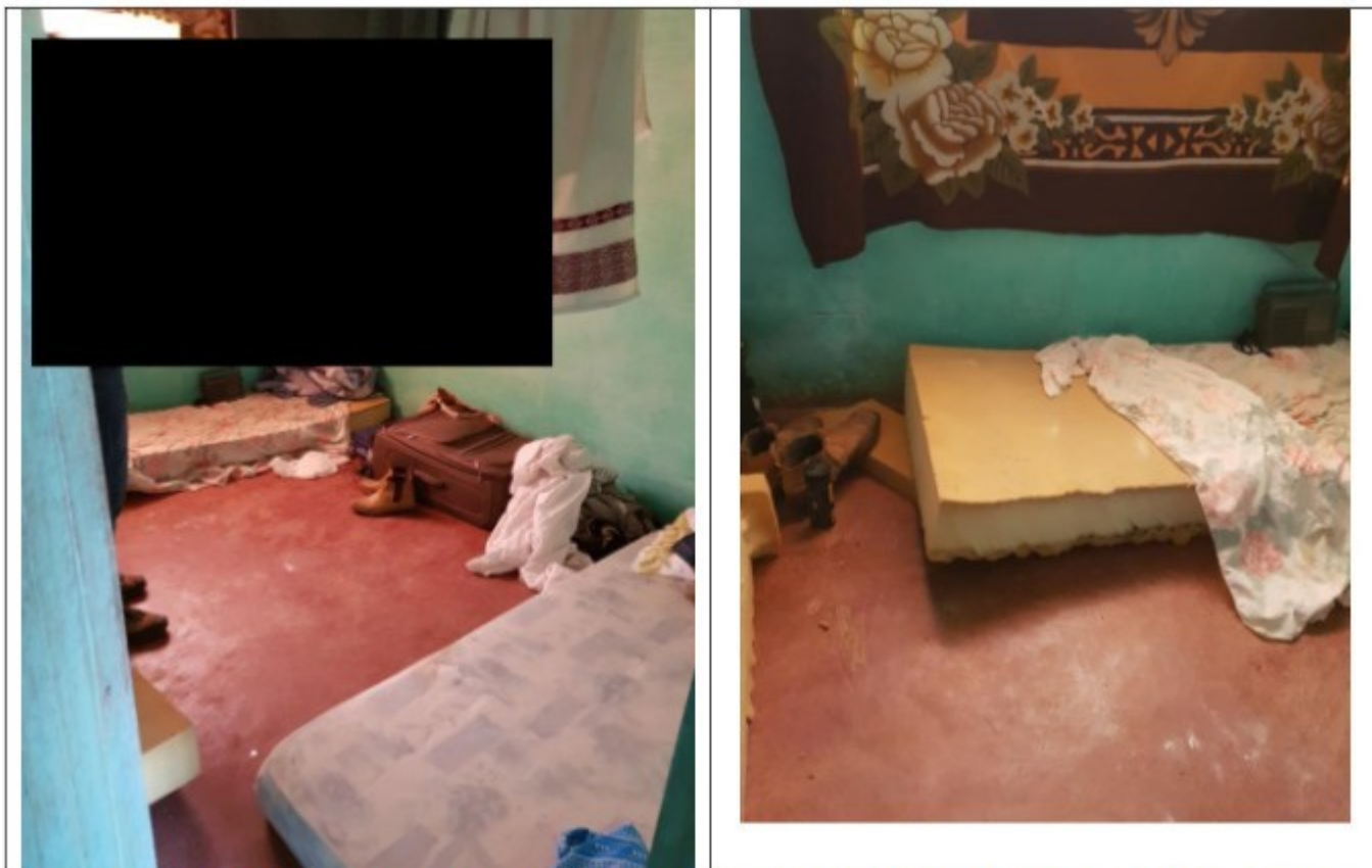
Fotos: Interior do alojamento com pertences dos trabalhadores espalhados pelos cômodos e com camas improvisadas e colchões (ou espumas) no chão.
