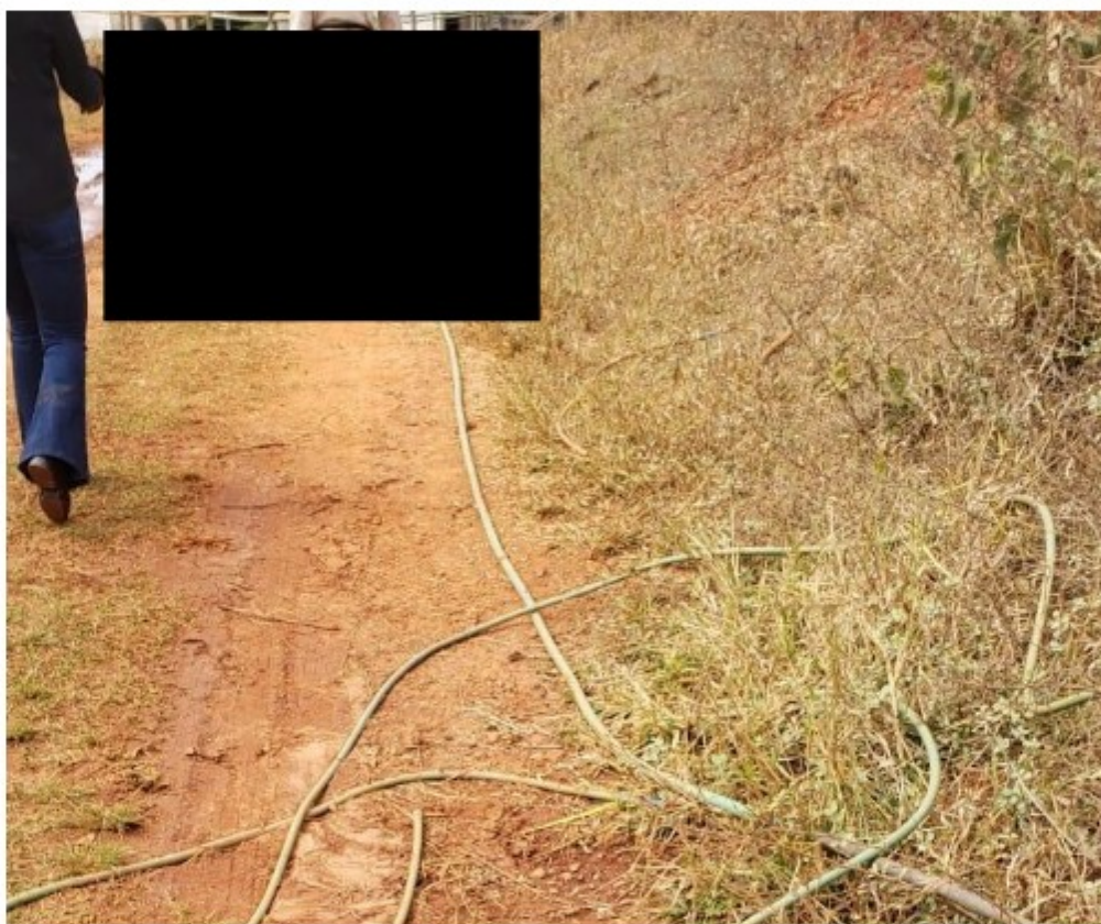
Figura 3: mangueira exposta e improvisada que levava água aos alojamentos
