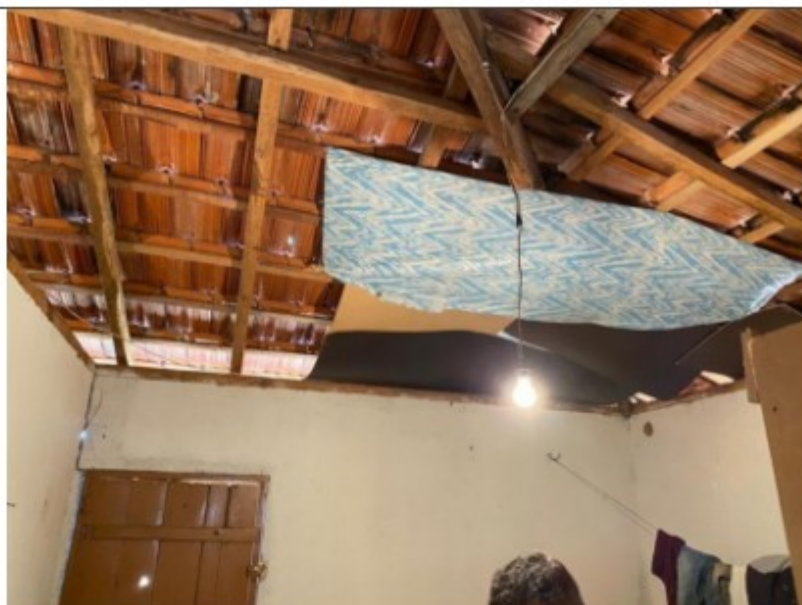
Fotos: Imagens das aberturas no telhado e na janela do alojamento.
