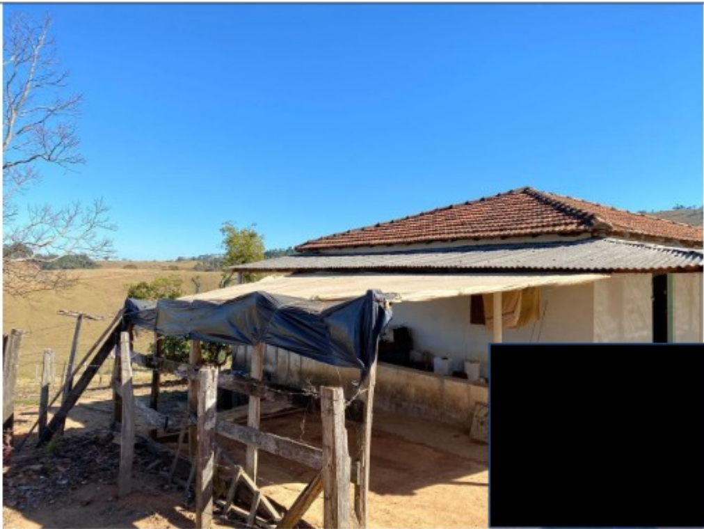
Foto: Vista externa do alojamento dos trabalhadores na Fazenda Vargem Limpa.
