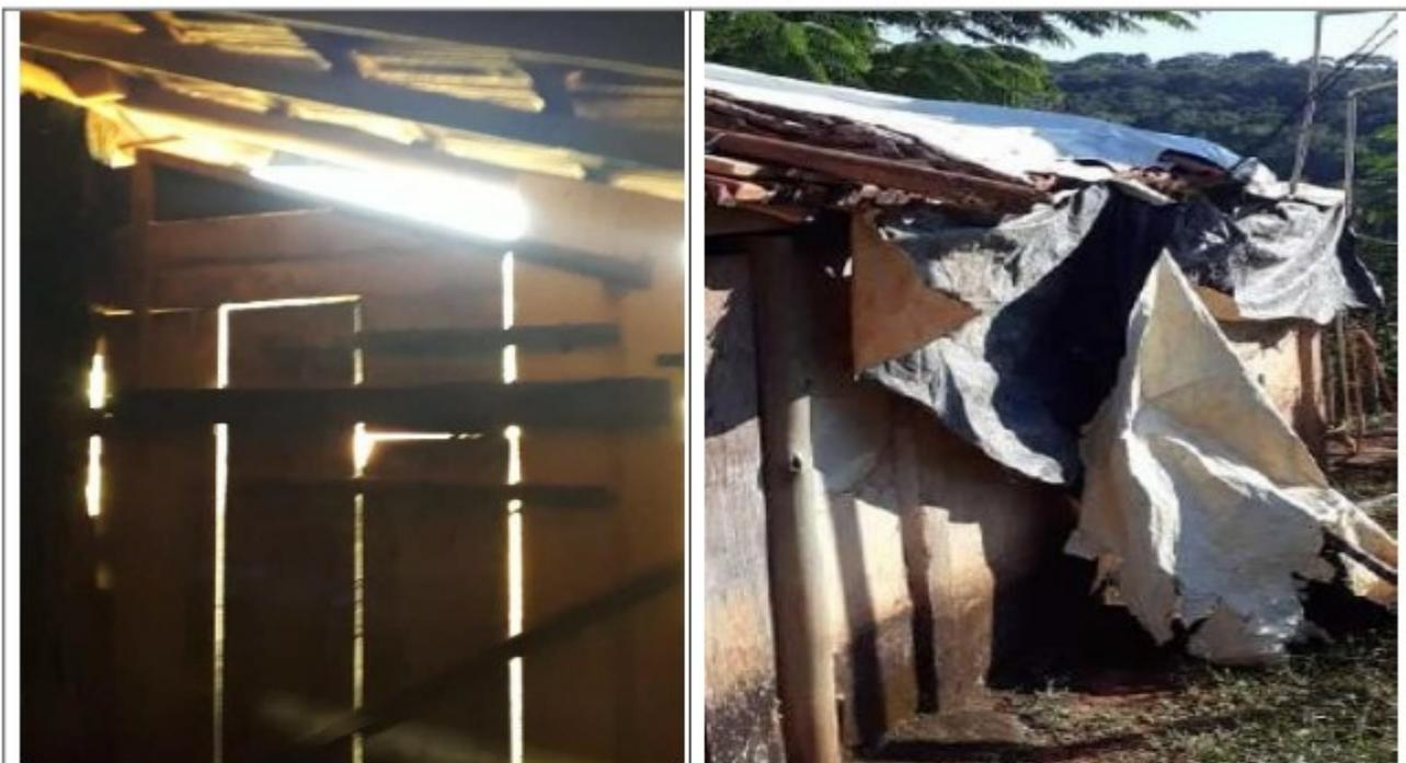
Figura 3: aberturas nas paredes e lonas sobre o telhado colocada pelo empregado para diminuir as goteiras das chuvas
