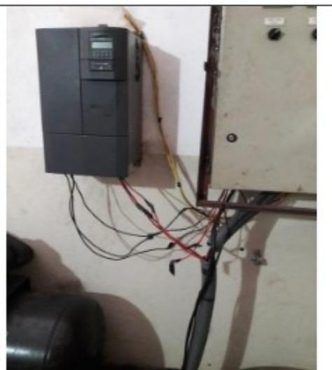
Foto 20- Emendas improvisadas na ligação entre o quadro de comando e o inversor.
