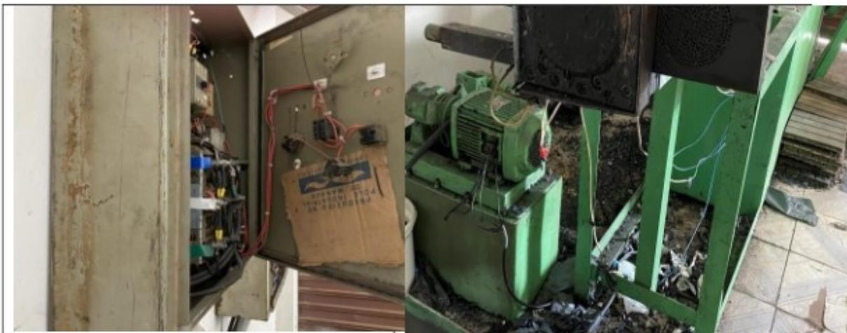
Foto 21- Quadro de força aberto com, com circuitos expostos.
