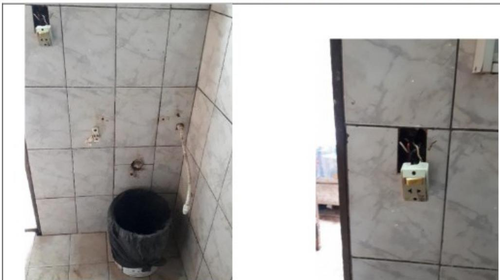
Foto 17 e 18- Banheiro existente no alojamento com interruptor e tomada com partes vivas expostas.
