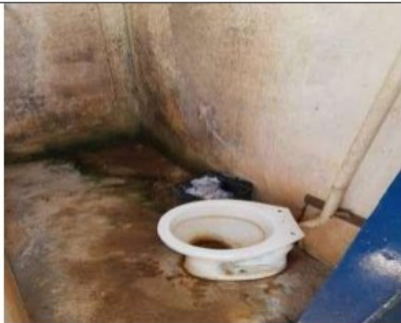
Instalações sanitárias, com um vaso sanitário e chuveiro
