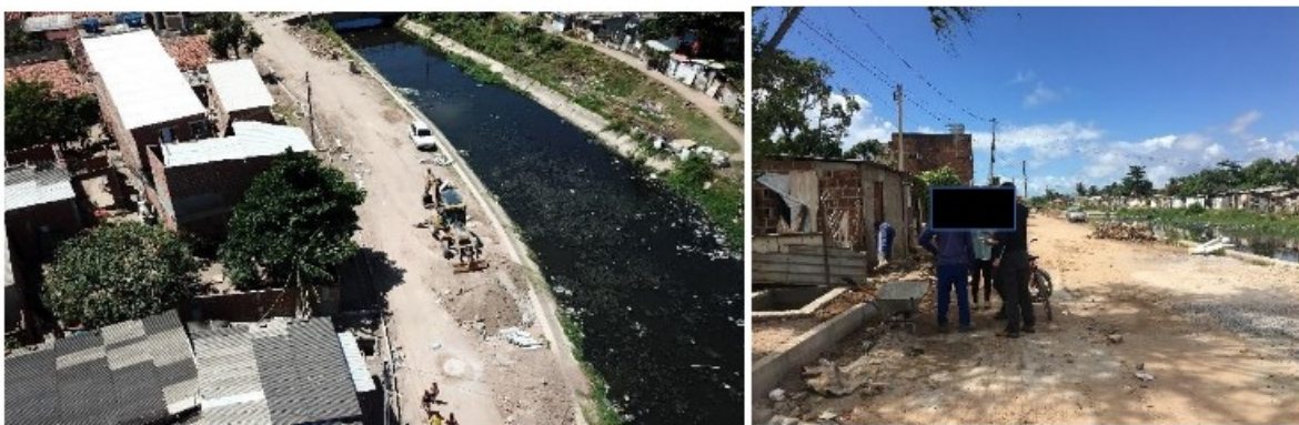
Fotos 1 e 2 – Vista aérea (obra de calçamento e pavimentação) e entrevista de trabalhador em plena atividade na obra fiscalizada.
