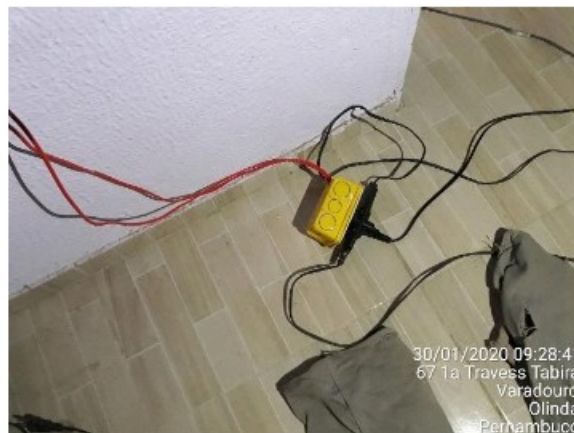
Fotos 7 e 8 – Improvisação para ligação de ventilador, gambiarras elétricas ao lado de espuma usada como colchão, onde um empregado dormia.
