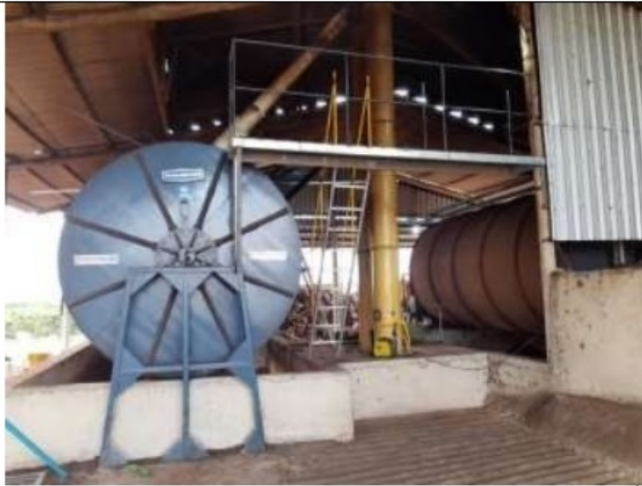
Construção de passarela, após a fiscalização, para trabalho em altura nos fornos.
