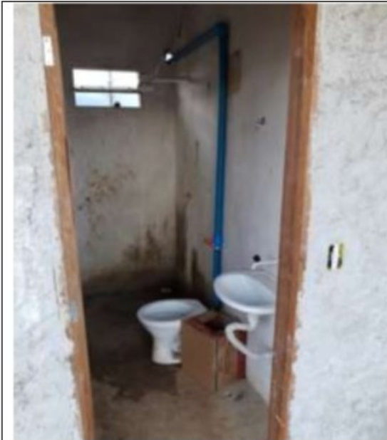
Instalações sanitárias ao lado da cozinha
