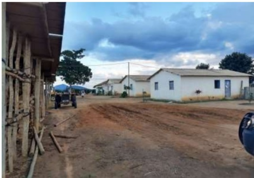
À direita, alojamentos dos empregados
