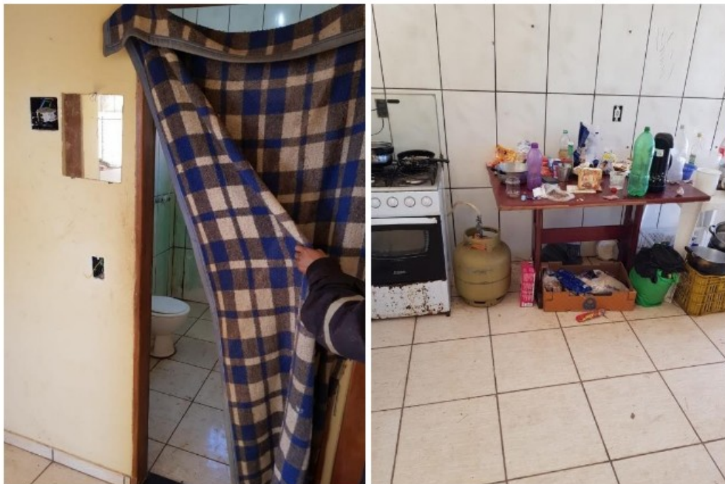
Fotos: Cobertor tapando o vão da porta do banheiro do alojamento e vista da cozinha.
